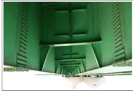
(원주방향) 가로보 상태양호
