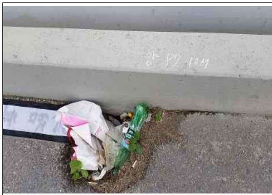
S7 (양평방향) 배수구막힘,그레이팅 유실
