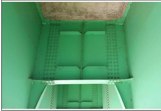
(양평방향) 가로보 상태양호
